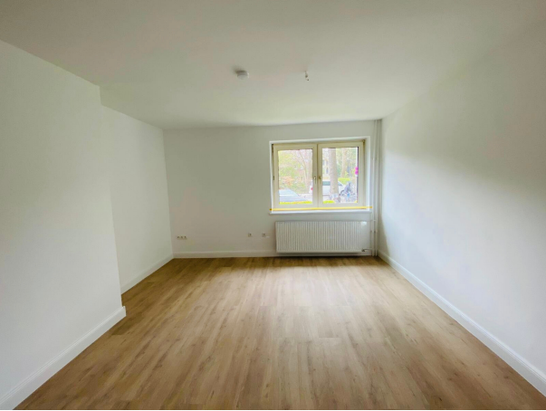
Beispiel nach Renovierung
