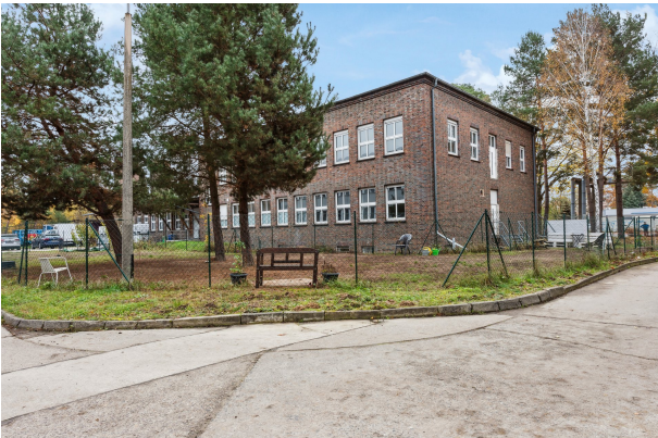
Gebäudeansicht von hinten
