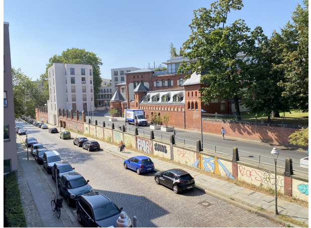
Blick zur Straße
